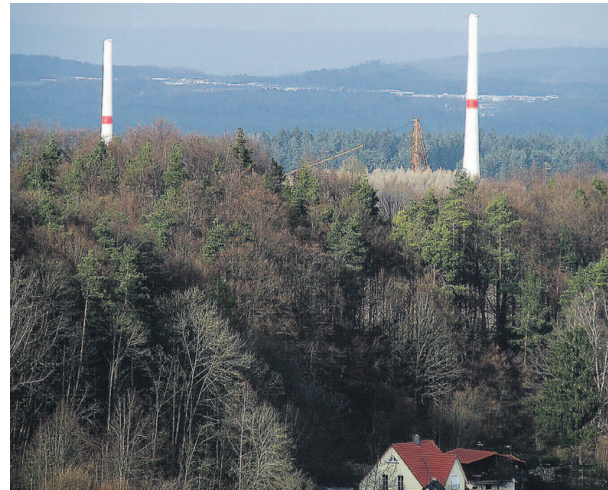
Die Windräder wurden vor Inkrafttreten der 10H-Regelung genehmigt. Sie stehen deshalb vergleichsweise nahe an der Bebauung.
