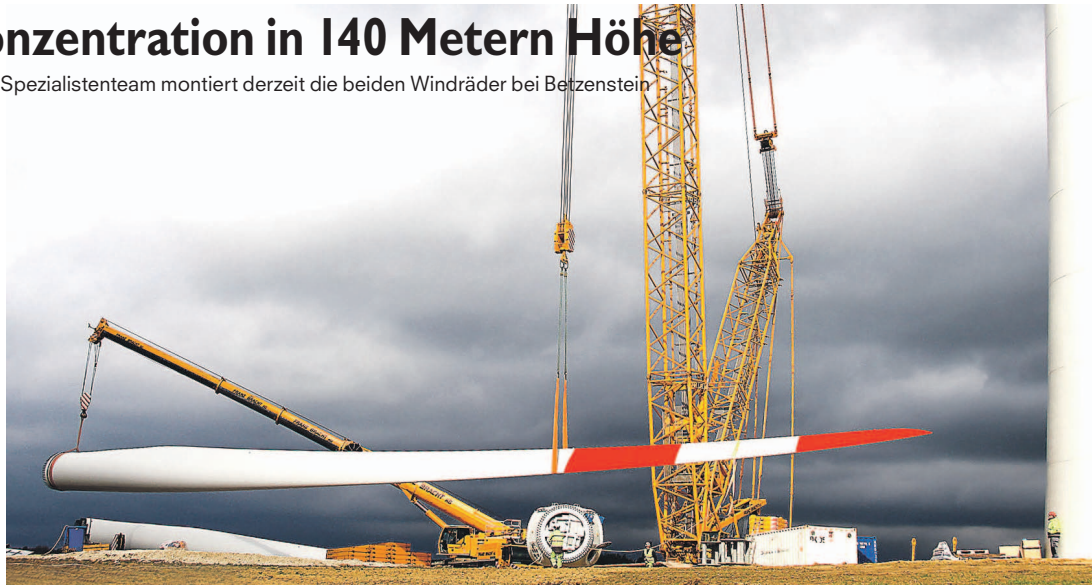
Mit einem 158 Meter hohen Aufstellkran werden die Teile der Windräder montiert – hier eines der Rotorblätter.
